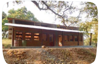
Construction de deux salles de classe Contribution 20 000 €
